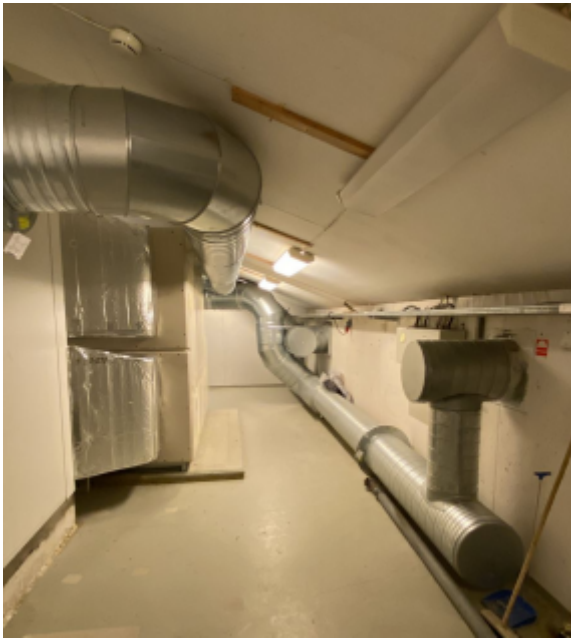
Figur 21 Ventilasjonkanaler i ventilasjonsrom i Etg 2.
