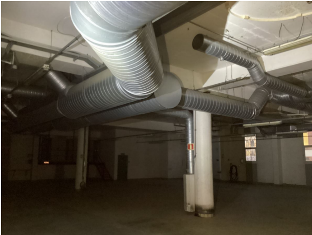
Figur 22 Ventilasjonskanaler.
